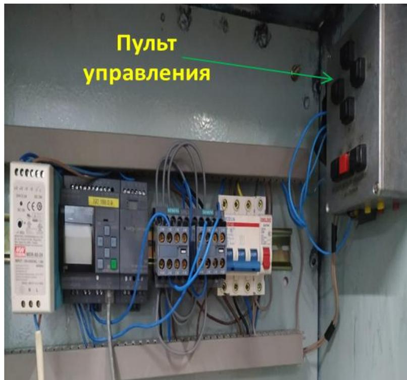
Рисунок 8 – Электрический щит с Logo- модулем
